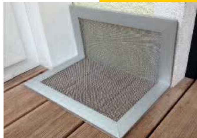
Lichtschachtabdeckung mit Aufkantung (Oberlichte)
