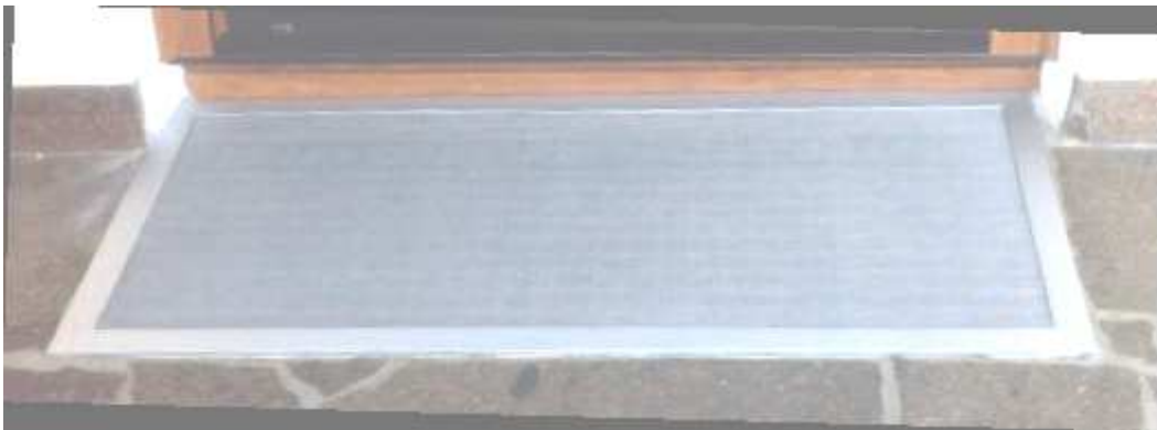
Lichtschachtabdeckung mit Alu-Rahmen in eloxierter Ausführung (Natur hell)
